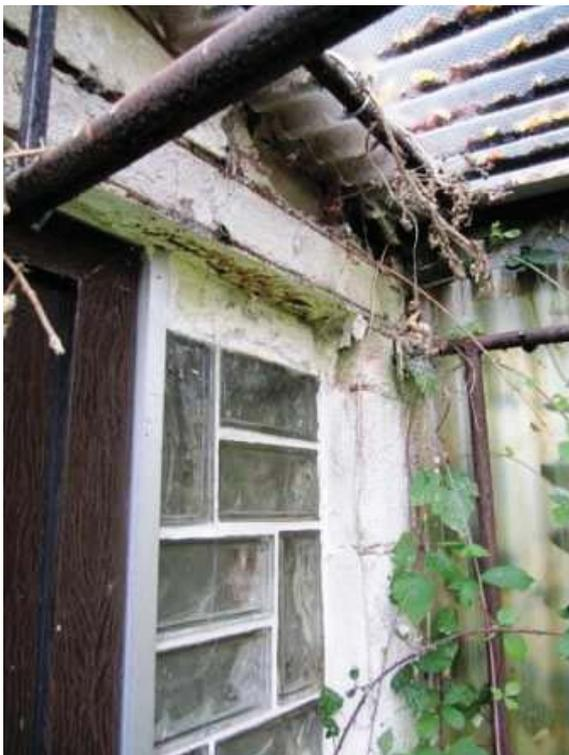
Detail Schäden im Sturzbereich, am Mauerwerk und an der Eingangsüberdachung
