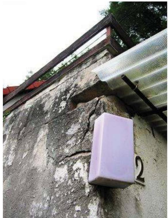
Detail Schäden im Anschlussbereich Decken (Flachdachterrasse) – Außenmauerwerk
